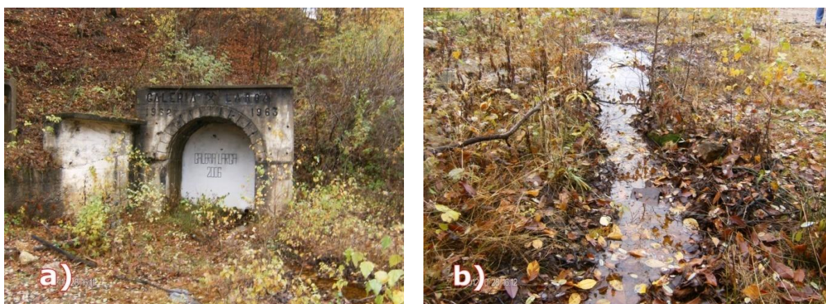
Figura 2.5. a) Galeria “Larga de Sus” (a); Canalul de scurgere al apei acide de mină (b) (noiembrie 2012)
